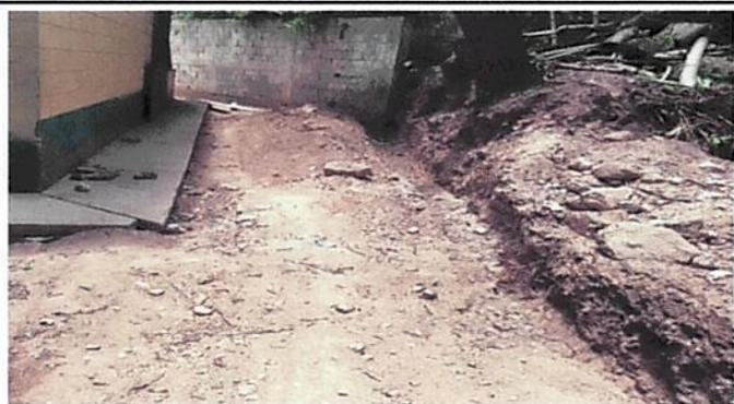
Foto 3: Se observa que inician a zanjar para empezar a levantar el muro perimetral faltante.
