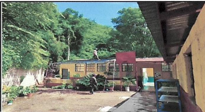
Foto 1: Se observa que proceden a retirar la lámina que está oxidada y en mal estado, para cambiarla por nueva.
