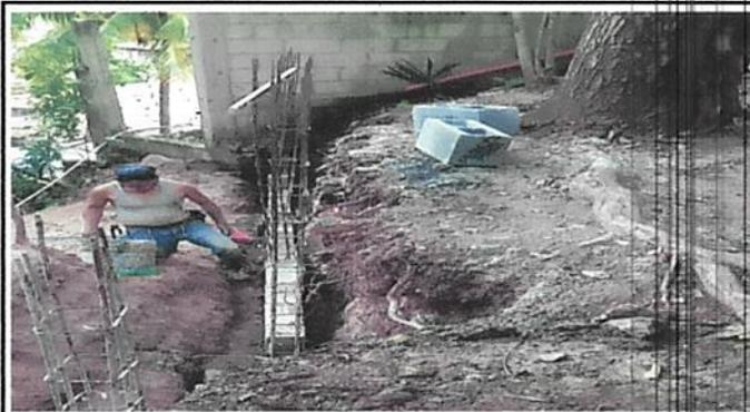
Foto 4: Se observa que dan inicio a levantar el muro perimetral de la parte de atrás de la escuela.
