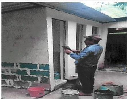
Foto 5: Se observa que proceden al remozamiento de los servicios sanitarios, cambio de piso de granito, cambio de tazas, repello, cambio de techo y estructura.
