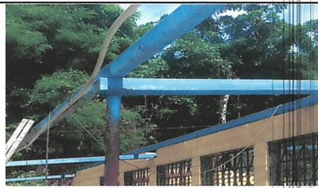
Foto 2: Proceden a lijar, pintar y reparar la estructura metálica.
